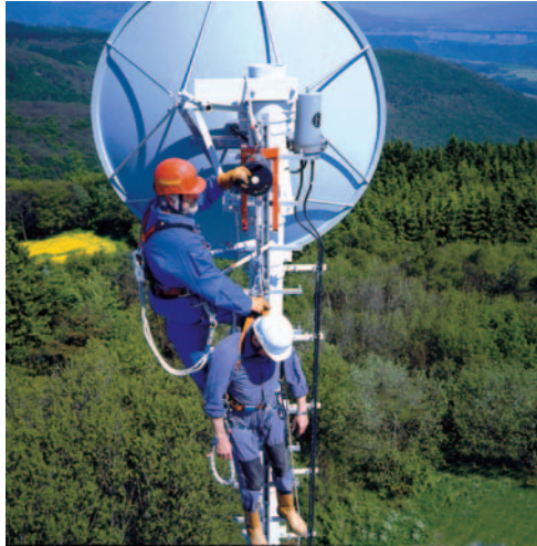
Bild 8: Abseilgerät mit integrierter Hubeinrichtung
