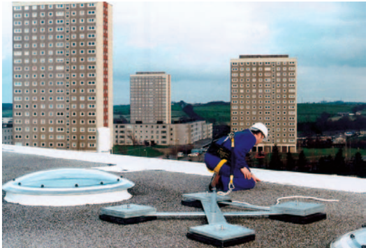
Bild 16: Durch Eigengewicht gehaltene Anschlageinrichtung (z.B. Betongewichte)
